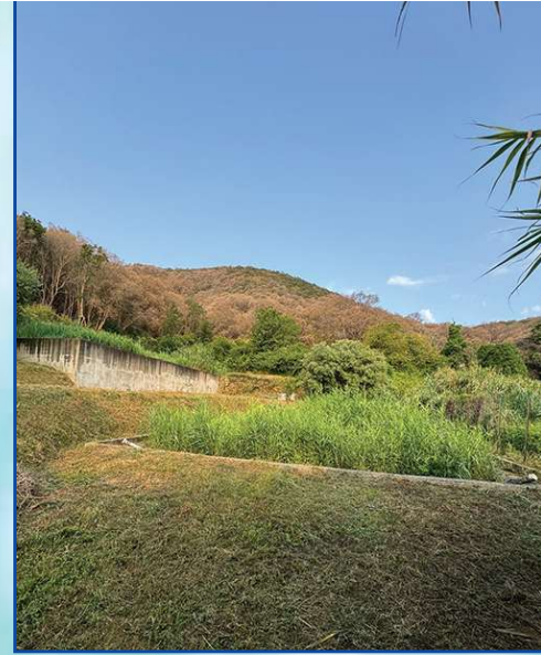
La Station d'épuration à Morteda
